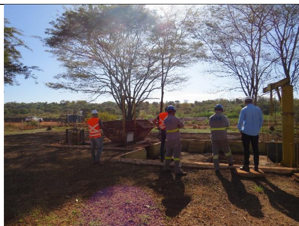
Autor: AMAE/RIO VERDE Descrição: acompanhamento da normalização da EEE Sapo pela equipe de fiscalização da AMAE/RIO VERDE. 15/07/22
