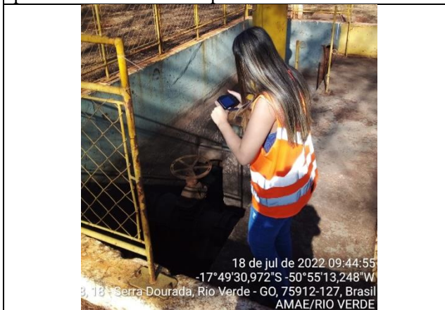
Autor: AMAE/RIO VERDE Descrição: acompanhamento da normalização da EEE Sapo pela equipe de fiscalização da AMAE/RIO VERDE. 18/07/22
