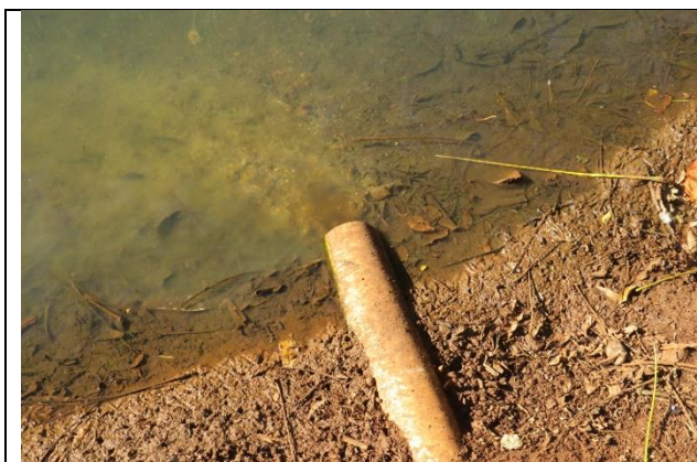
Autor: AMAE/RIO VERDE Descrição: lançamento de esgoto doméstico bruto em pontos difusos no Córrego das Mangueiras, nas proximidades da EEE Sapo. 15/07/22
