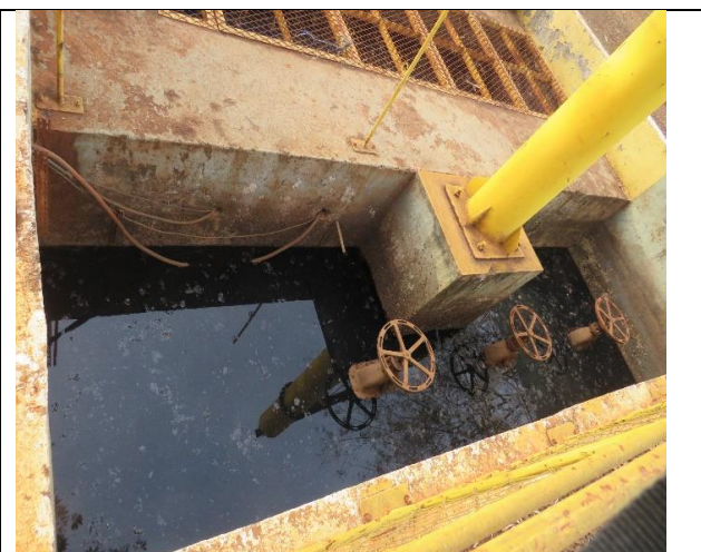
Autor: AMAE/RIO VERDE Descrição: esgoto reservado no Poço de sucção da EEE Sapo. 14/07/22
